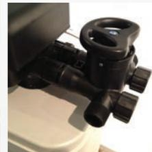
Insertar el By-pass en la válvula
