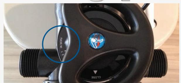
Realizada la despresurización, compruebe la estanqueidad de todas las conexiones. Deje correr el agua durante unos minutos para eliminar posibles residuos en tuberías.
