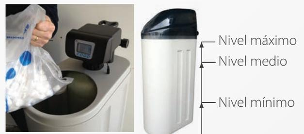
Lors du remplissage en sel du réservoir, veillez à ne pas verser de sel dans le tuyau de protection de la canne à saumure.
